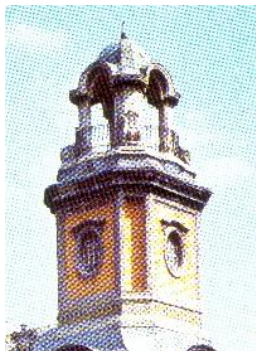
Tisza Szálló és Gyógyfürdő tornya (Verseghy park)
